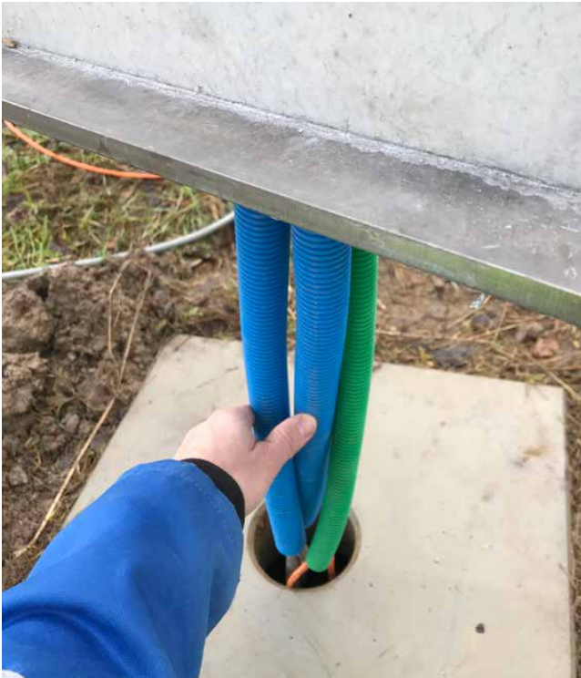
Einführen der Kabelschutzrohre
