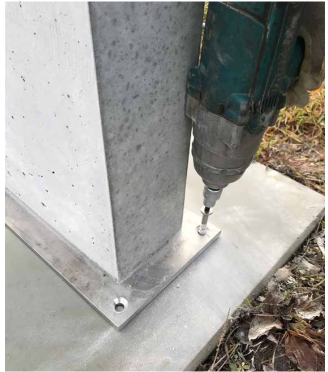
Befestigung des Betonelements
